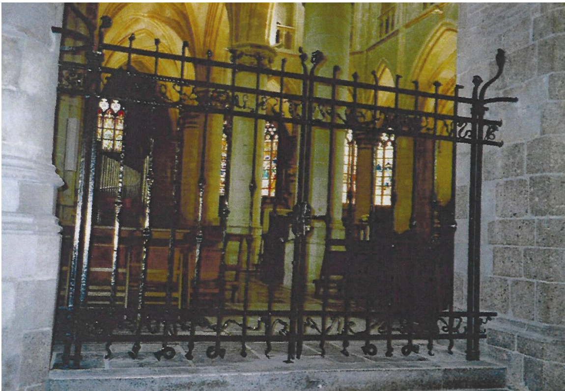
Er komt een hekwerk tussen het schip en de koorkerk.
